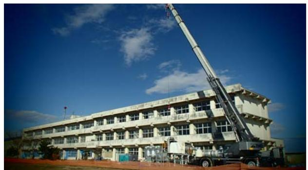
図4 東北地方に緊急設置されたマイクロ波方式アスベスト無害化処理。この試験では、処理施設として津波により無人となった校舎を利用している。
